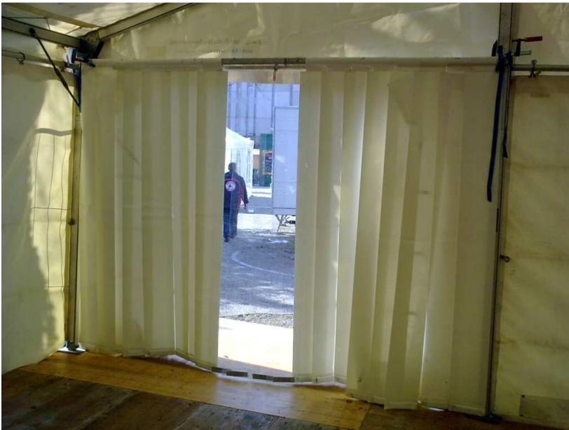
Abb. 1: Notausgang mit Lamellen
