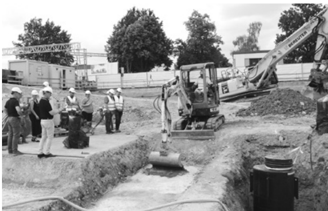
Die kleine Grube für die Grundsteinlegung wird ausgehoben.
