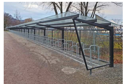
Abstellanlage bei Sport- & Freizeitanlage
