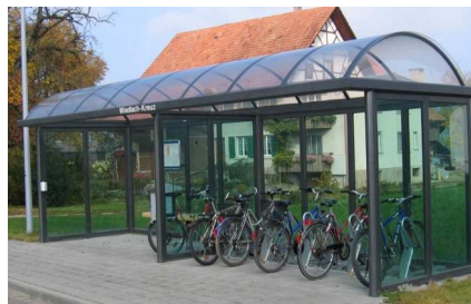
Abstellanlage an Bushaltestelle
